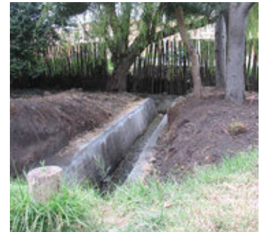
Canalización de aguas
