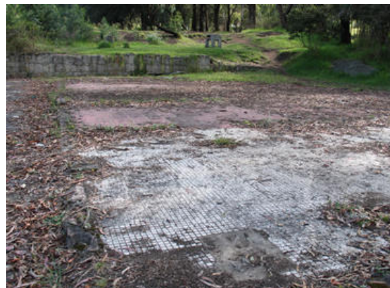
Ruinas de demolición de antiguo restaurante.
